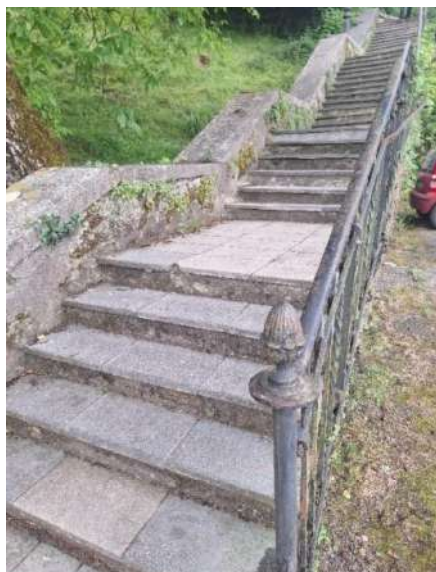
Figura 3. Escaleras para acceder a la estación de Legazpia.
