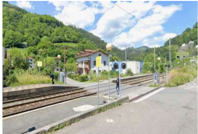
Figura 8. Cruce de vías en Itsasondo.
