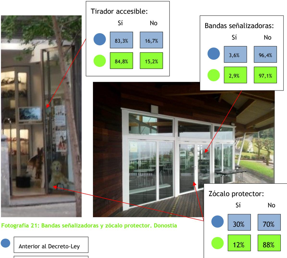
Fotografía 21: Bandas señalizadoras y zócalo protector. Donostia
